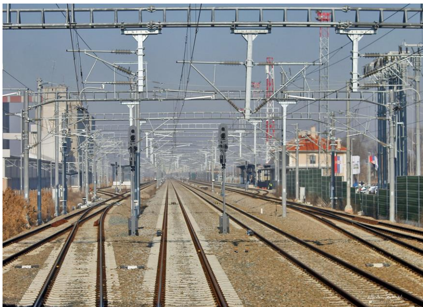
контактна мрежа – портали у реону станице
